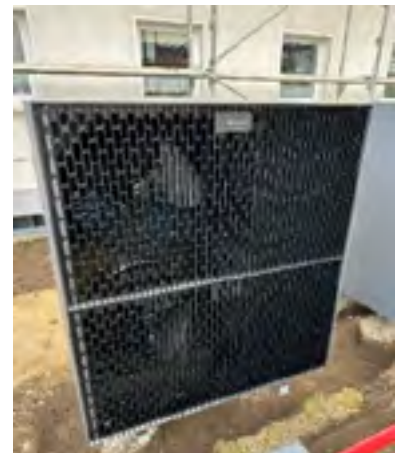
Ahornstraße 19/21: Umstellung von Gas- auf Wärmepumpenbetrieb mit Photovoltaikunterstützung
