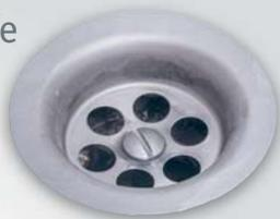
Wenn Wannen- oder Dusch-Abläufe abgeschraubt werden – sei es zur Reinigung oder anderen Zwecken –, gelingt den wenigsten Wohnungsnutzern anschließend die Montage in den Ausgangszustand. Da die Schraube den gesamten Wannenablauf einschließlich der Dichtungen – auch den nicht sichtbaren Teil – zusammenhält, kommt es bei Fehlmontage häufig zu einem folgenschweren Wasserschaden.
